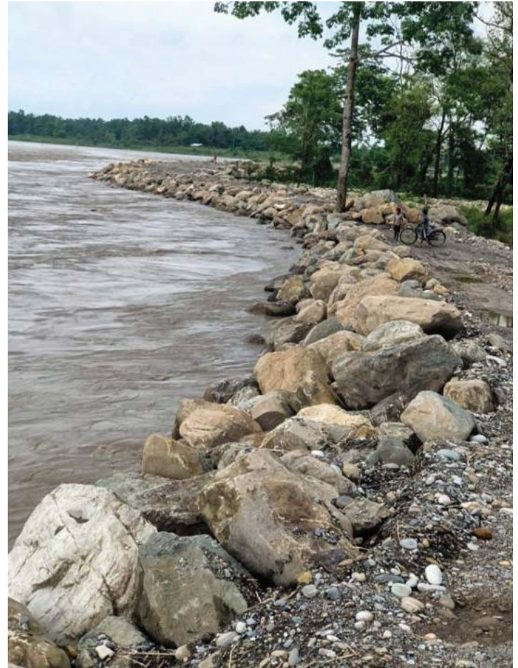
Flood Fighting कार्य अन्तर्गत Big Boulder Rip-Rip गरिएको
